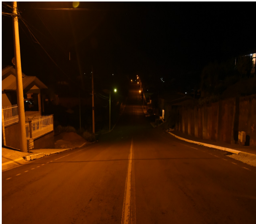
Figura 3 – Exemplo de via com iluminação atual subdimensionada atendida pelo Procel Reluz
